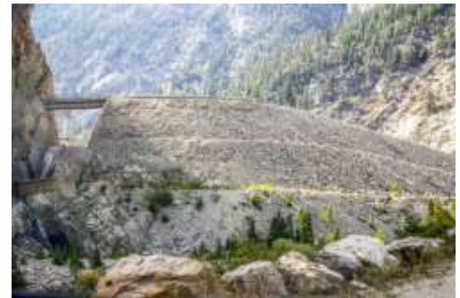
Évacuateur de crues du barrage Terzaghi (2015).
