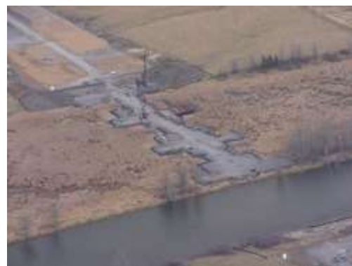
Construction des fondations sur les tourbières.
