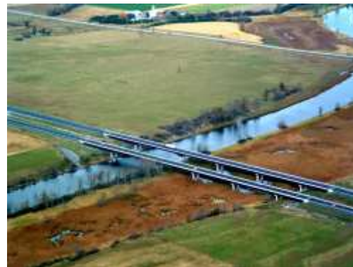
Pont jumelé de l'autoroute 417 enjambant la rivière Mississippi et les tourbières adjacentes.
