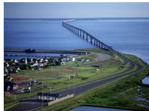
Pont après sa construction (1998).
