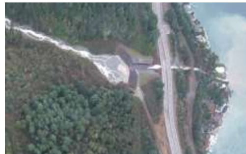
Vue aérienne de la structure d'atténuation du ruisseau Charles.
