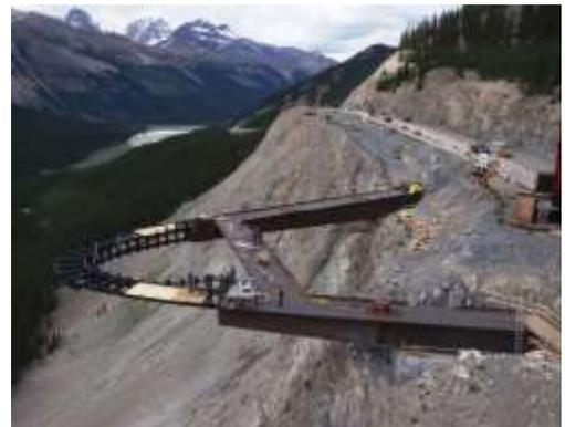
Vue aérienne lors de la construction montrant les larges semelles et la pente rocheuse abrupte.
