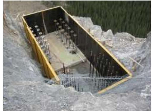
Vue de la semelle nord lors de la construction ; on voit les micropieux et les nombreux ancrages au roc.
