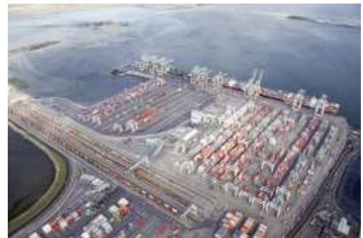
Agrandissement du poste d'amarrage 3 de Deltaport.
