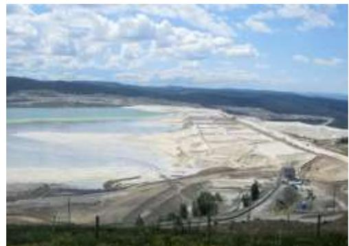
Construction de la digue L-L au moyen de cyclones.
