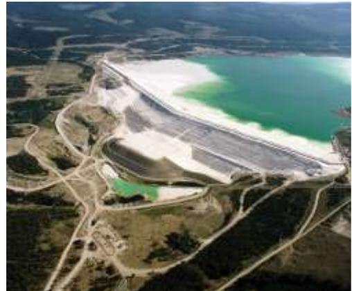
Partie nord de la digue L-L d'une hauteur de 166m.
