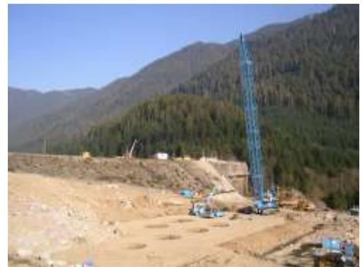
Densification par compaction dynamique des fondations du barrage (2005).
